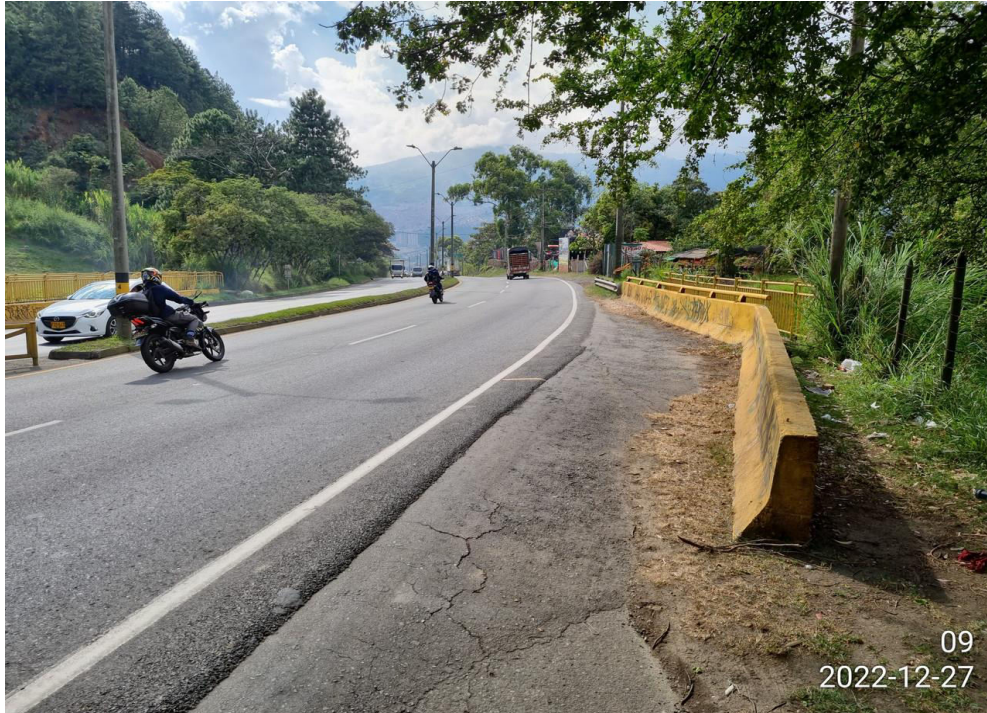
Puente en general
