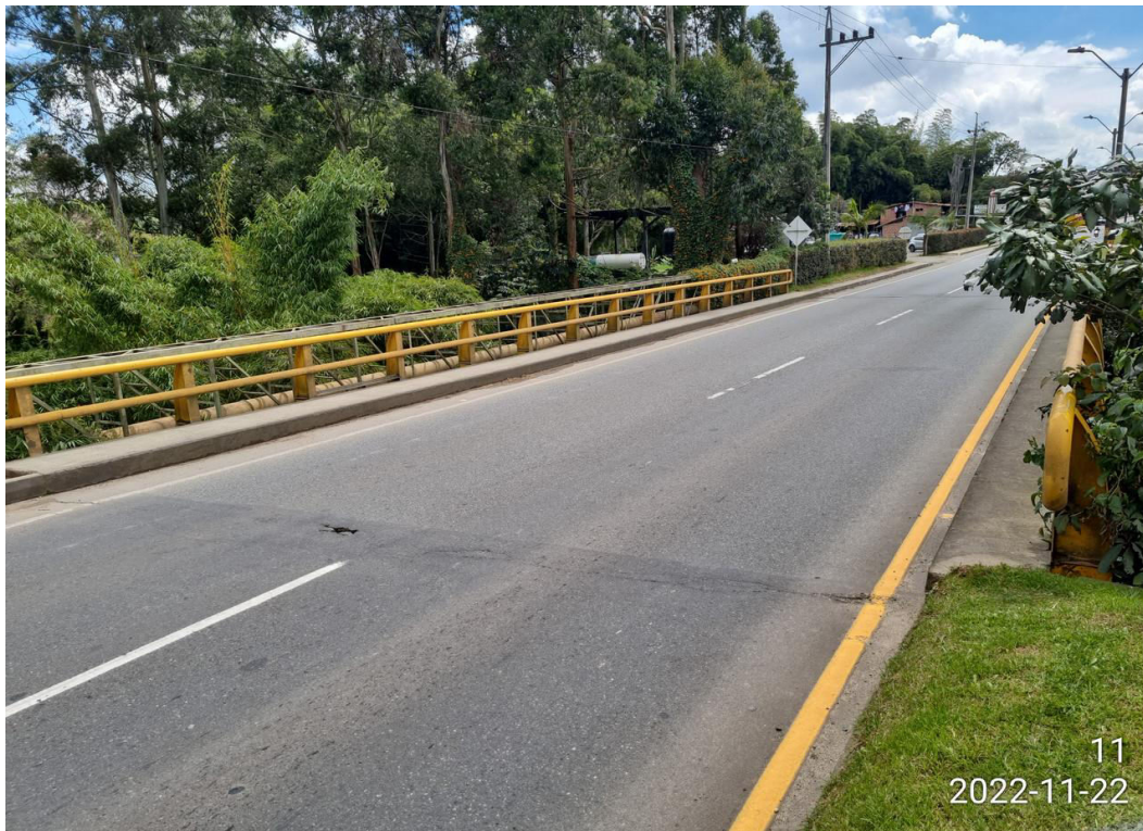
Puente en general
